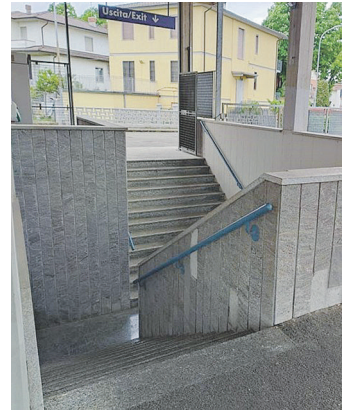
Le scale che portano ai binari F. PADERNI
