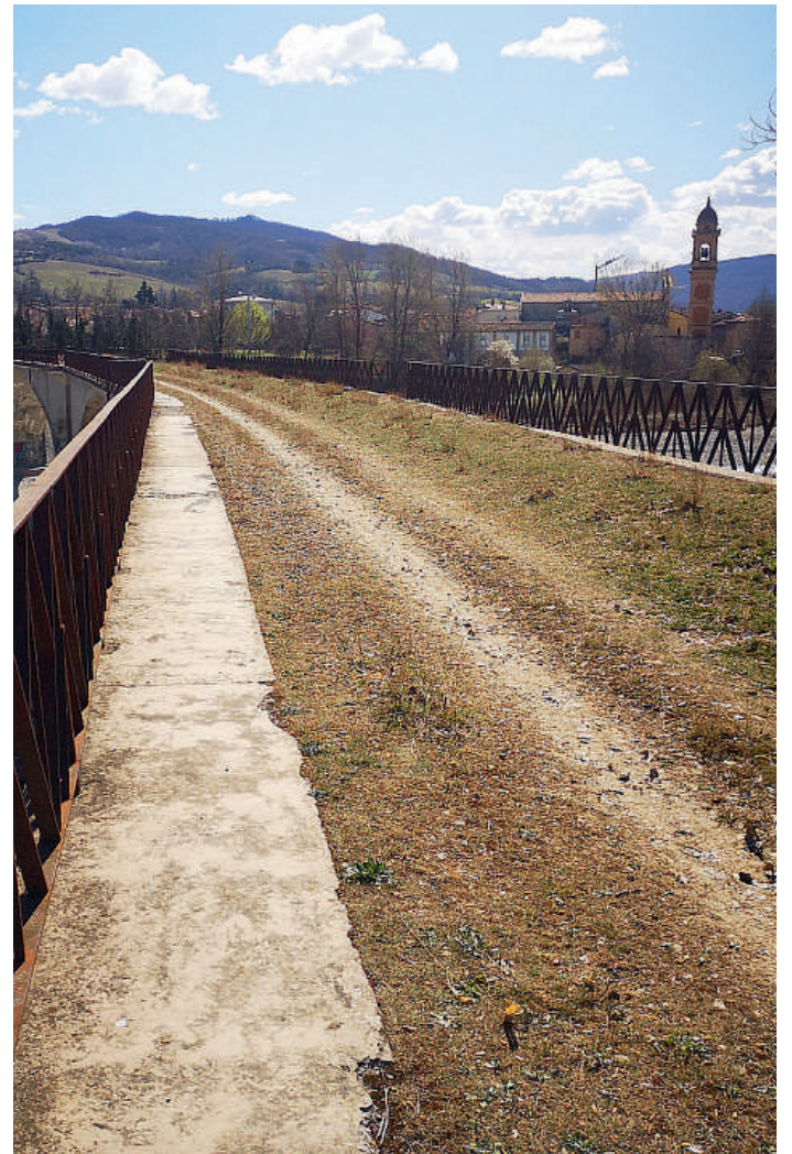
In alto e qui sopra il viadotto ferroviario sul Nure a Pontedellolio
